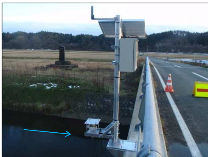
一級河川 旭川 秋田市添川字蓬田(湯沢橋)
