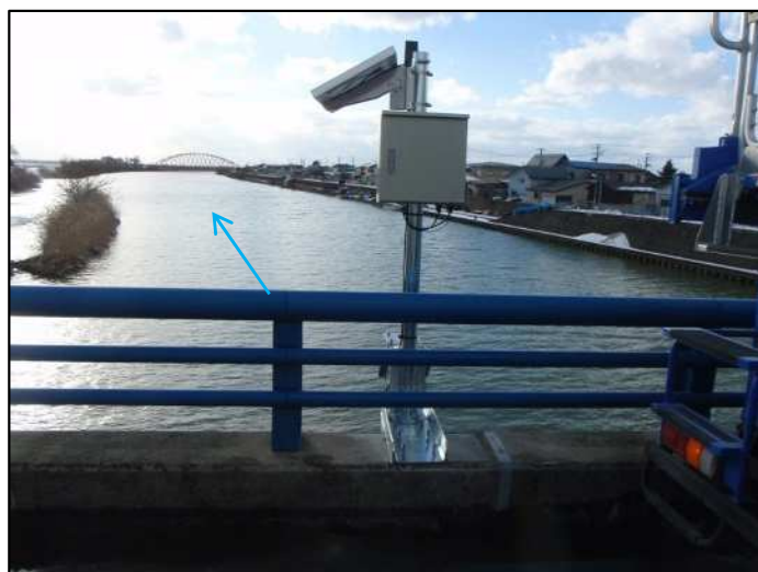
二級河川 馬場目川 五城目町大川大川字下川原(竜馬橋)
